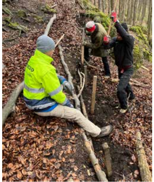
Fleißige Baumeister bei der Arbeit
