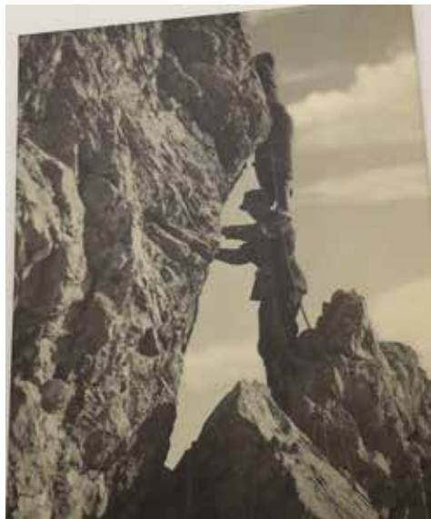
„Gebaut“ wird nicht nur in Sachsen – ein historisches Foto aus dem Treppenhaus
